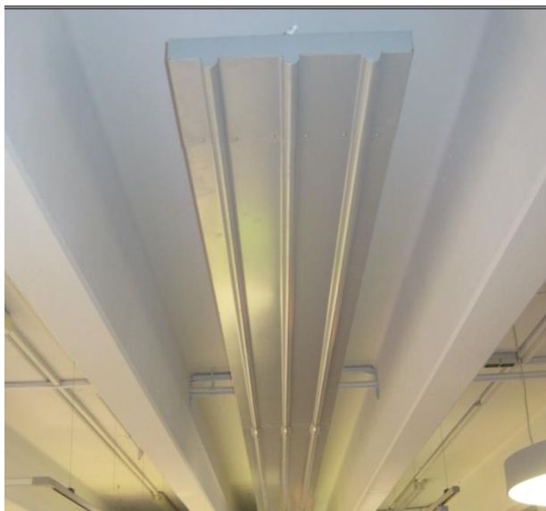
Abbildung 4.7 Deckenstrahlplatten im Ausstellungsbereich [1]
