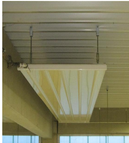
Abbildung 4.7 Deckenstrahlplatten im Ausstellungsbereich [1]
