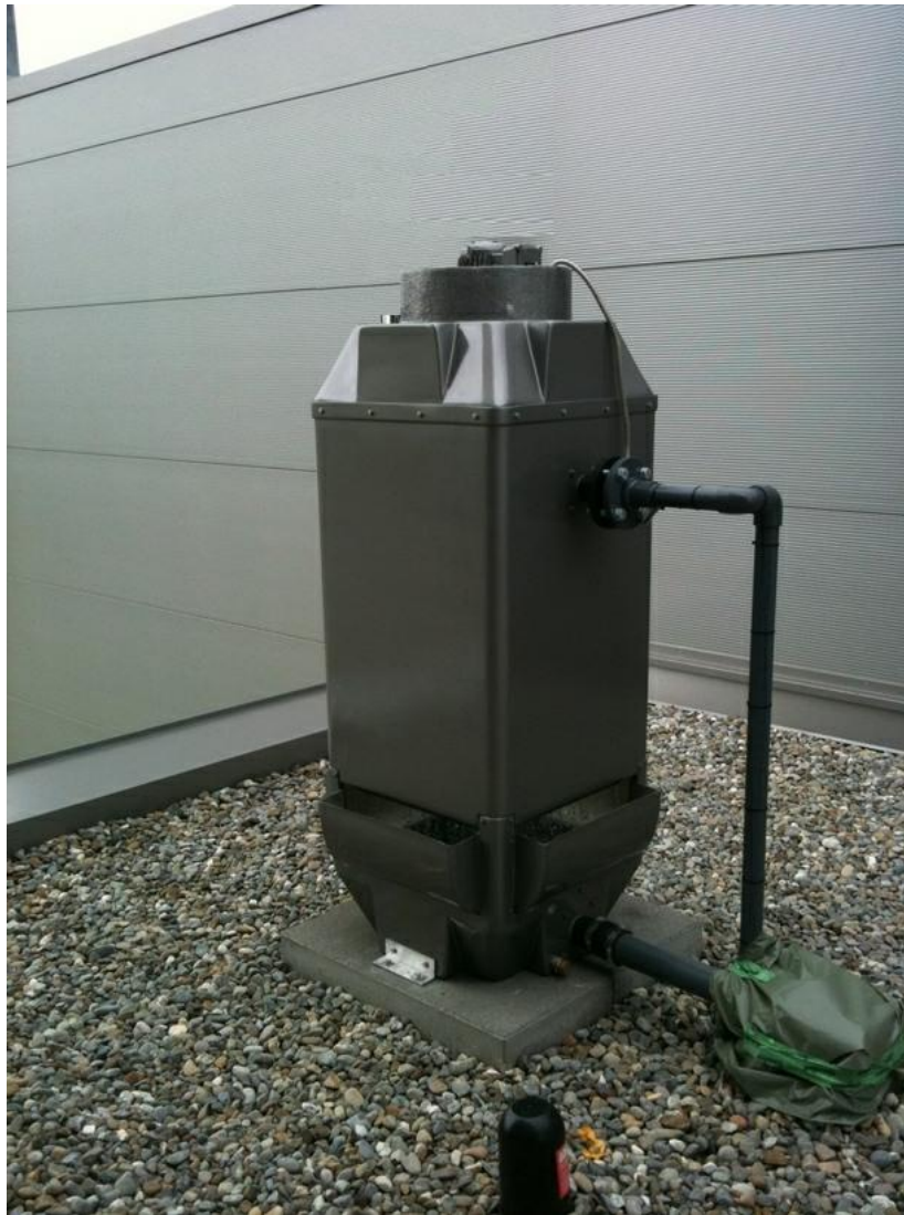
Abbildung 5.10 Kühlturm der Firma Huckle mit einer Rückkühlleistung von 43 kW [29]
