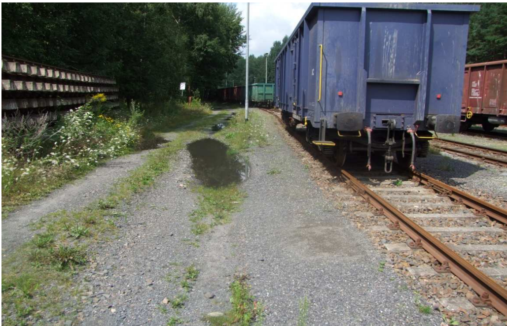
Blick auf geplante Station 0+072,310 m Gleis A4
