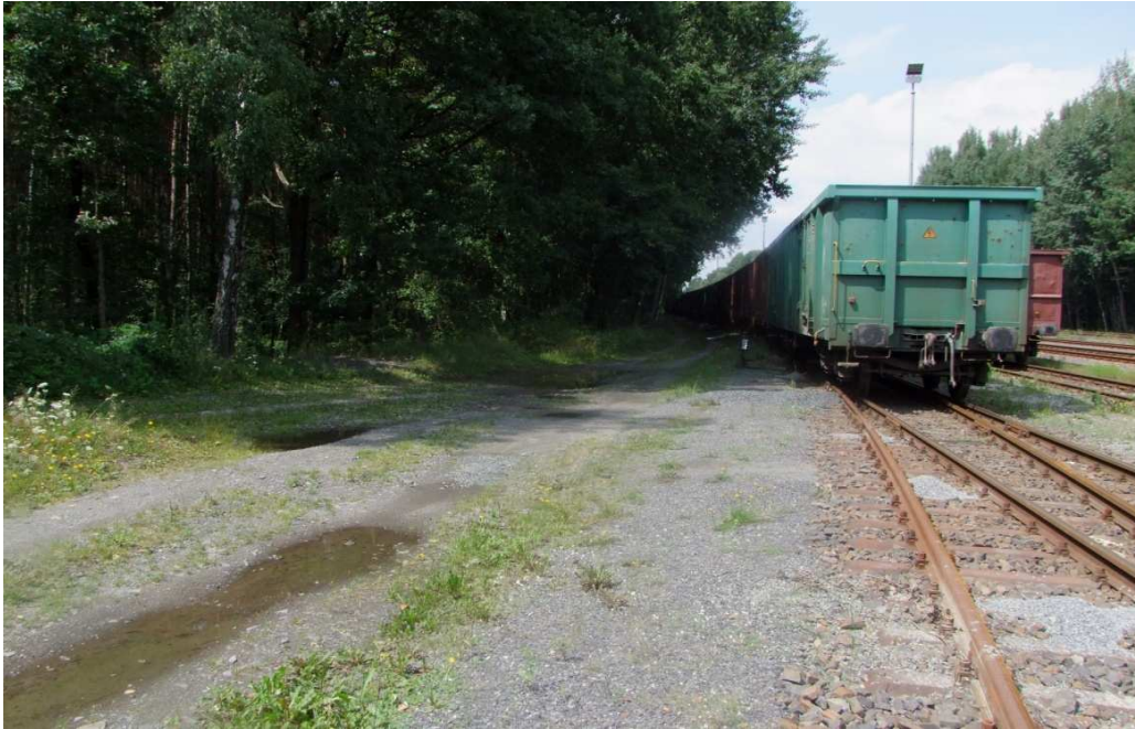
Blick auf geplante Station 0+230,000 m Gleis A3
