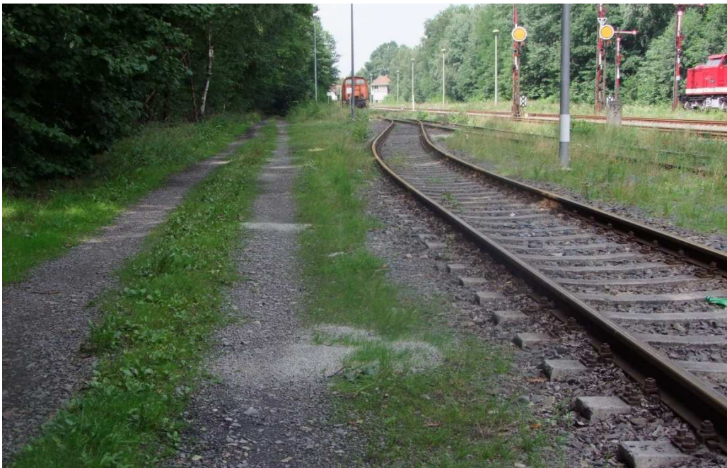
Blick auf geplante Station 0+000,000 m Gleis A3
