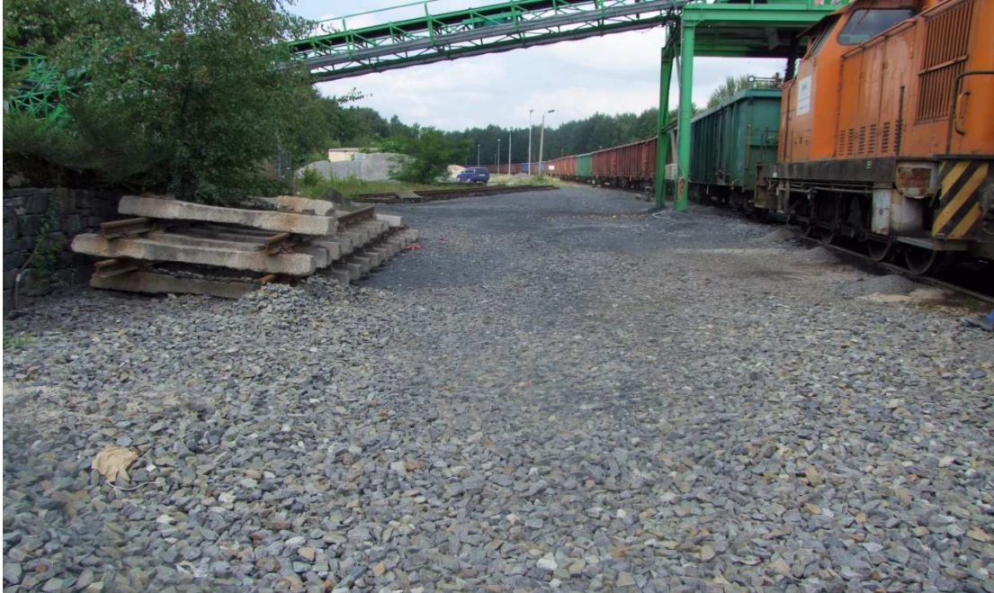
Blick auf geplante Station 0+610,000 m Gleis A3
