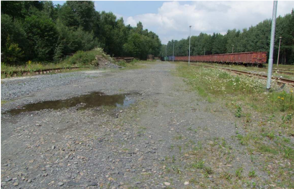
Blick auf geplante Station 0+040,000 m Gleis A5
