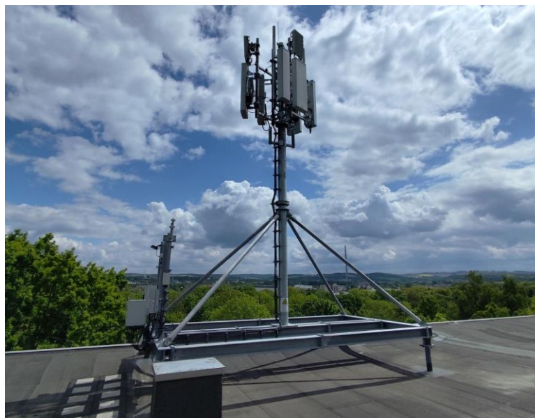
Abbildung 2 Abgestrebter Stahlrohrmast mit Untergerüst auf Dach Foto eines realisierten Projektes
