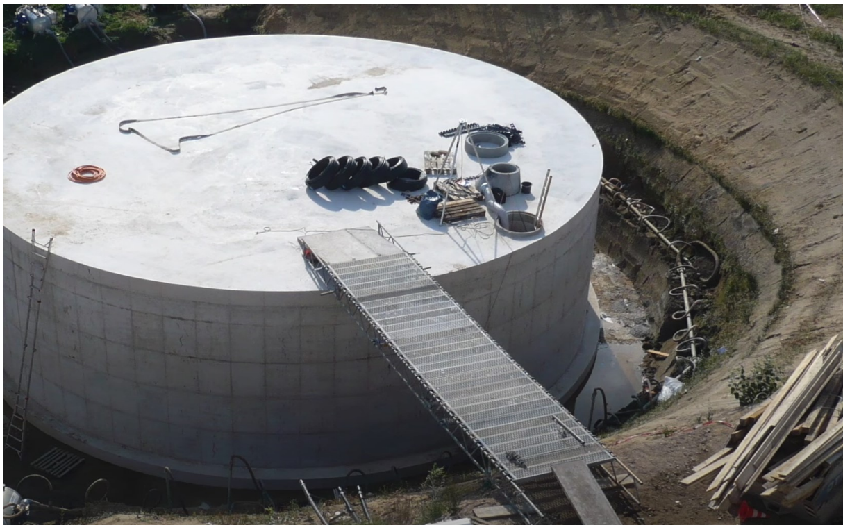
Abbildung 9 Wasserbehälter eines Eisspeicher-Systems (Quelle: Viessmann)
