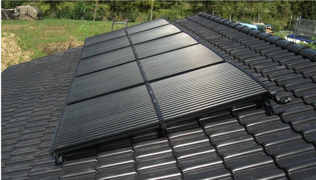
Abbildung 10 Solar-Luft-Absorber (Quelle: Viessmann)
