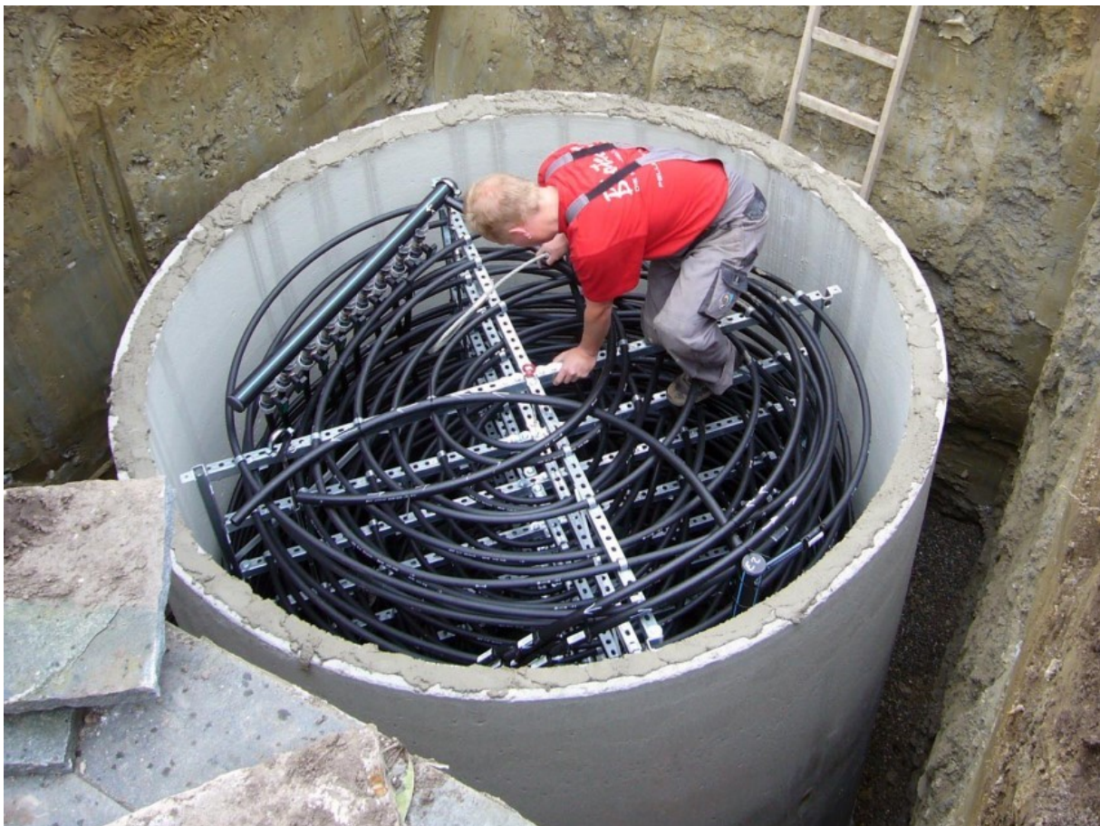
Abbildung 14 Wärmeübertrager im Wasserbehälter (Quelle: Viessmann)
